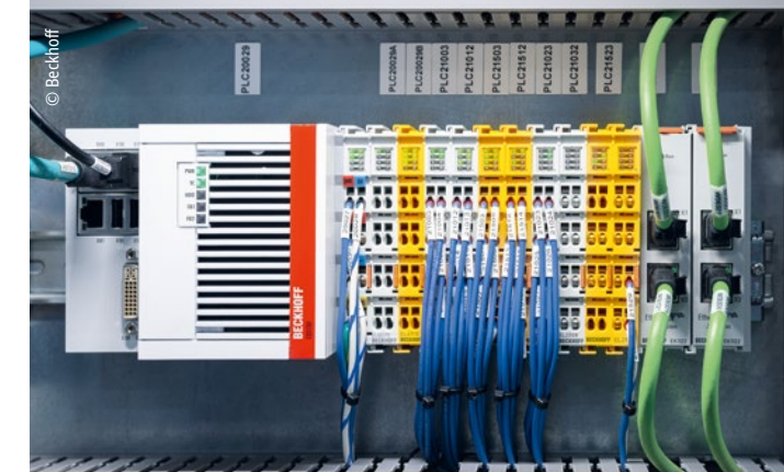
Ein Embedded-PC CX5130 von Beckhoff dient als zentrale Maschinensteuerung für das robotergestützte Prüfzentrum.
