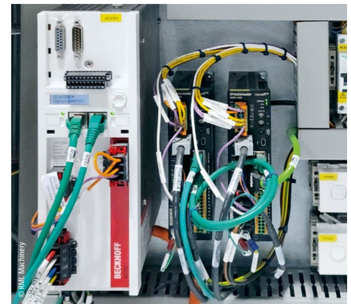
Ein Servoverstärker AX5103 mit TwinSAFE-Optionskarte AX5805 ergibt präzise und zuverlässige Bewegungen.
